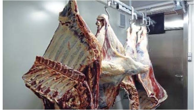
Über die Rohrbahnanlage können Fleischteile oder Tierhälften in den nachgelagerten Kühlraum verbracht werden.
