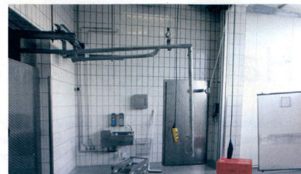
Mit einem von außen begehbaren Lager wird verhindert, dass Lieferanten den Betrieb betreten müssen.
